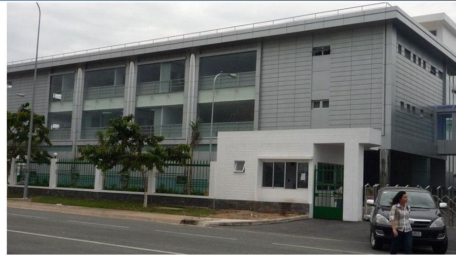
● NHÀ KIỂM NGHIỆM
