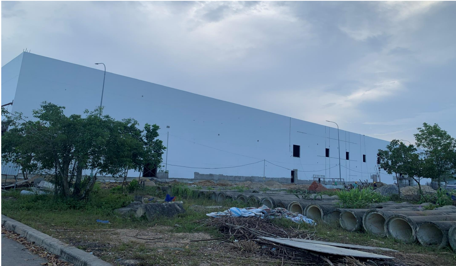
● HÌNH ẢNH THI CÔNG
