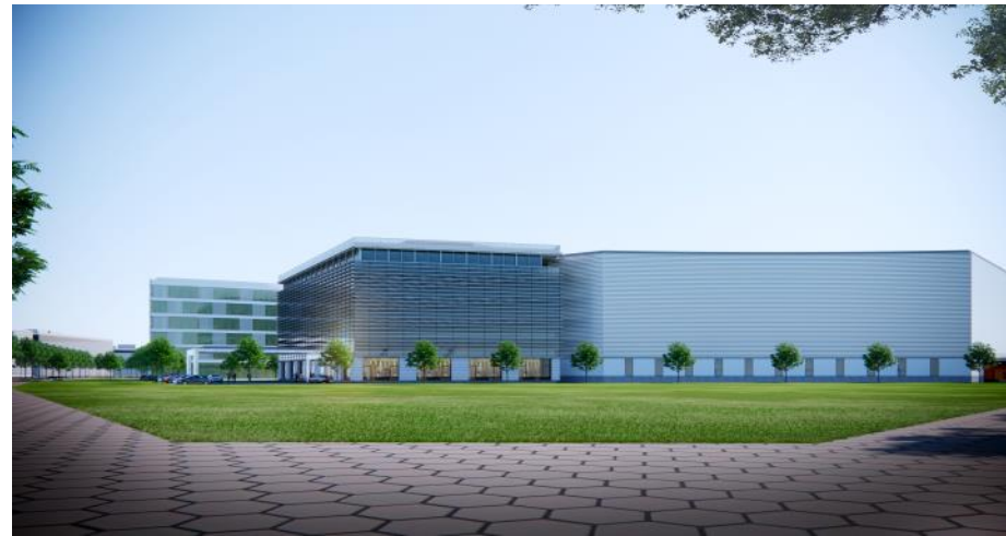
● NHÀ XƯỞNG VÀ NHÀ DỊCH VỤ
