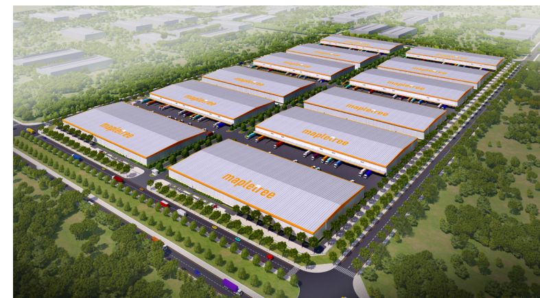
Nhà kho Logistics tại Hưng Yên - Mapletree Địa điểm: KCN Viglacera Yên Mỹ I, Hưng Yên - Quy mô: 280.000m 2
